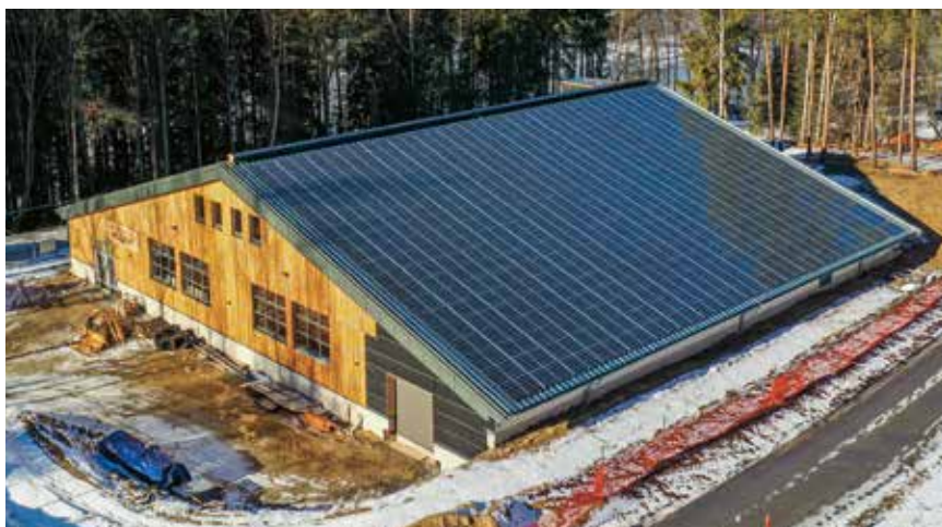
Auf dem Dach des Veranstaltungshauses wurde eine 300kWp PV-Anlage installiert.
